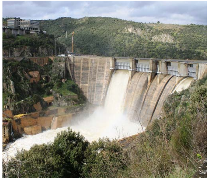
Bemposta Dam, Douro River
