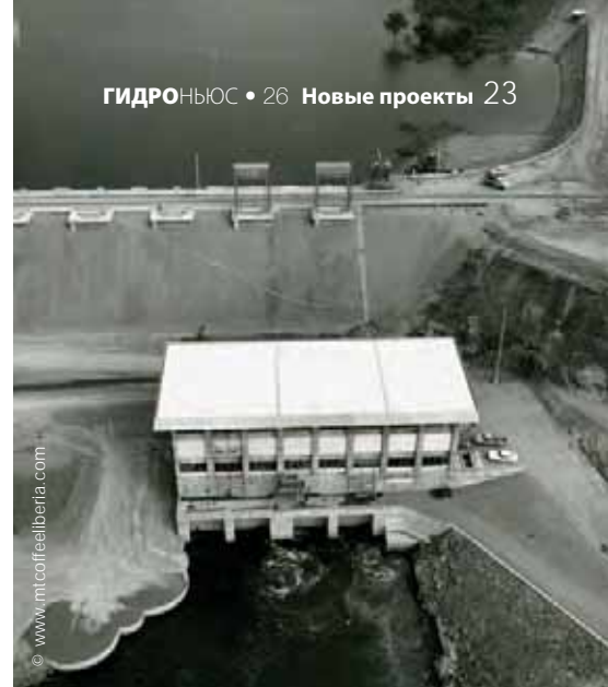
Вид ГЭС сверху при первом вводе в эксплуатацию
