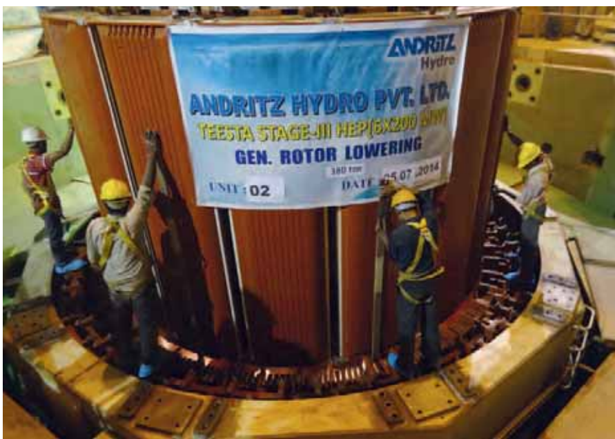
□ Установка ротора агрегата №2
