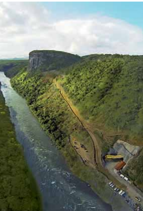
□ Река Кванза и подъездные пути к будущей ГЭС «Lausa»
