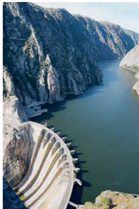
▣ Вид на водохранилище из диспетчерского пункта
