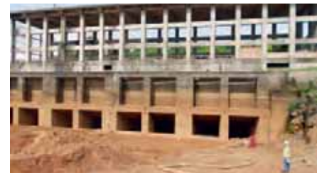
Текущее состояние ГЭС
