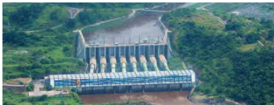
■ Вид гидроэлектростанции «Inga 2» с высоты птичьего полёта
