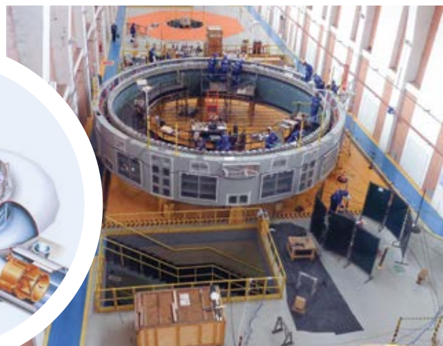
Les alternateurs de Belo Monte ont une puissance de production de 679 MVA et un impressionnant diamètre de stator de 18,5 m.
